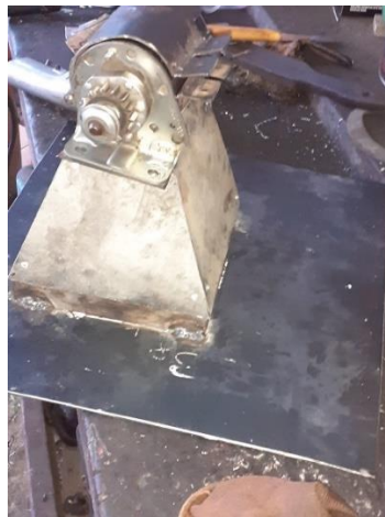
Ilustración 3. 6. Sellado de la Estructura para mejorar su estética
