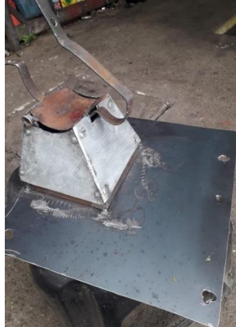
Ilustración 3. 11. Construcción de la nueva estructura de apoyo
