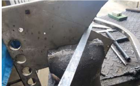
Figura 18: Corte de soportes de columna.
