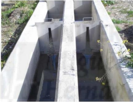
Figura IV.2 Ejemplo de un desarenado de flujo horizontal.
