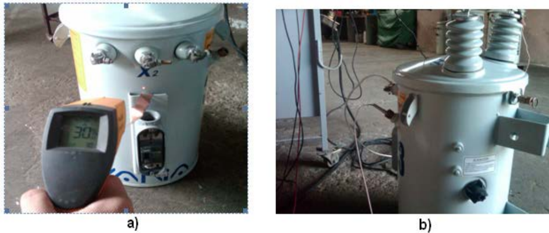
FIGURA 6.11 TOMA DE TEMPERATURA (A) AMBIENTE, (B) ACEITE POR MEDIO DE TERMOCUPLA
