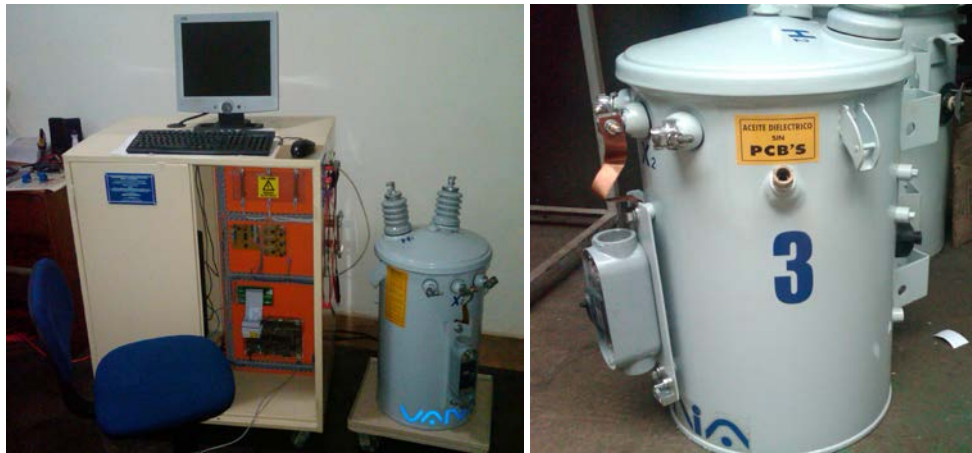
FIGURA 6.2 (A) MÓDULO DIDÁCTICO DE ADQUISICIÓN DE SEÑALES, (B) TRANSFORMADOR DE DISTRIBUCIÓN
