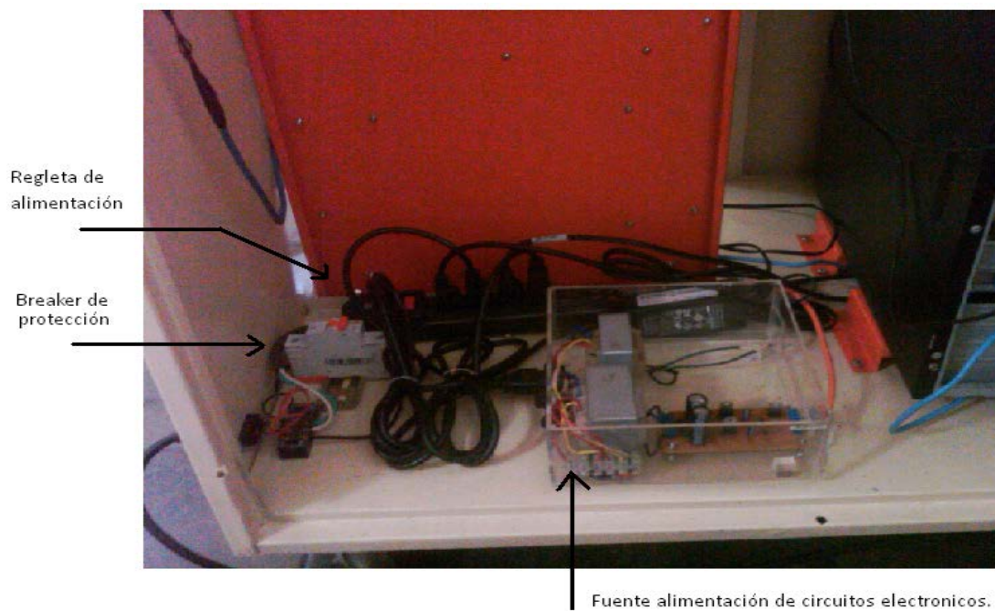
FIGURA 7.2 REGLETA DE ALIMENTACIÓN, BREAKER DE PROTECCIÓN, FUENTE DE ALIMENTACIÓN DE CIRCUITOS
