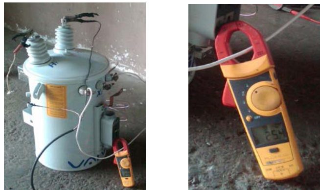
FIGURA 6.12 TRANSFORMADOR CONECTADO A CORRIENTE NOMINAL 100%
