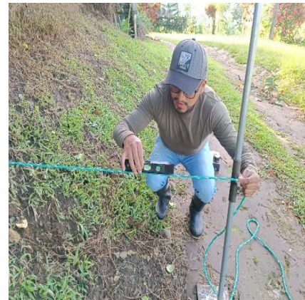
Figura 23. Instalación de la herramienta y cuerda para el ensayo.
