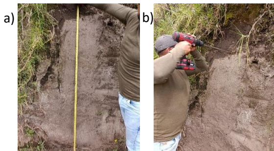
Figura 19. a) Alturas de perforación, b) Perforación de anclajes.
