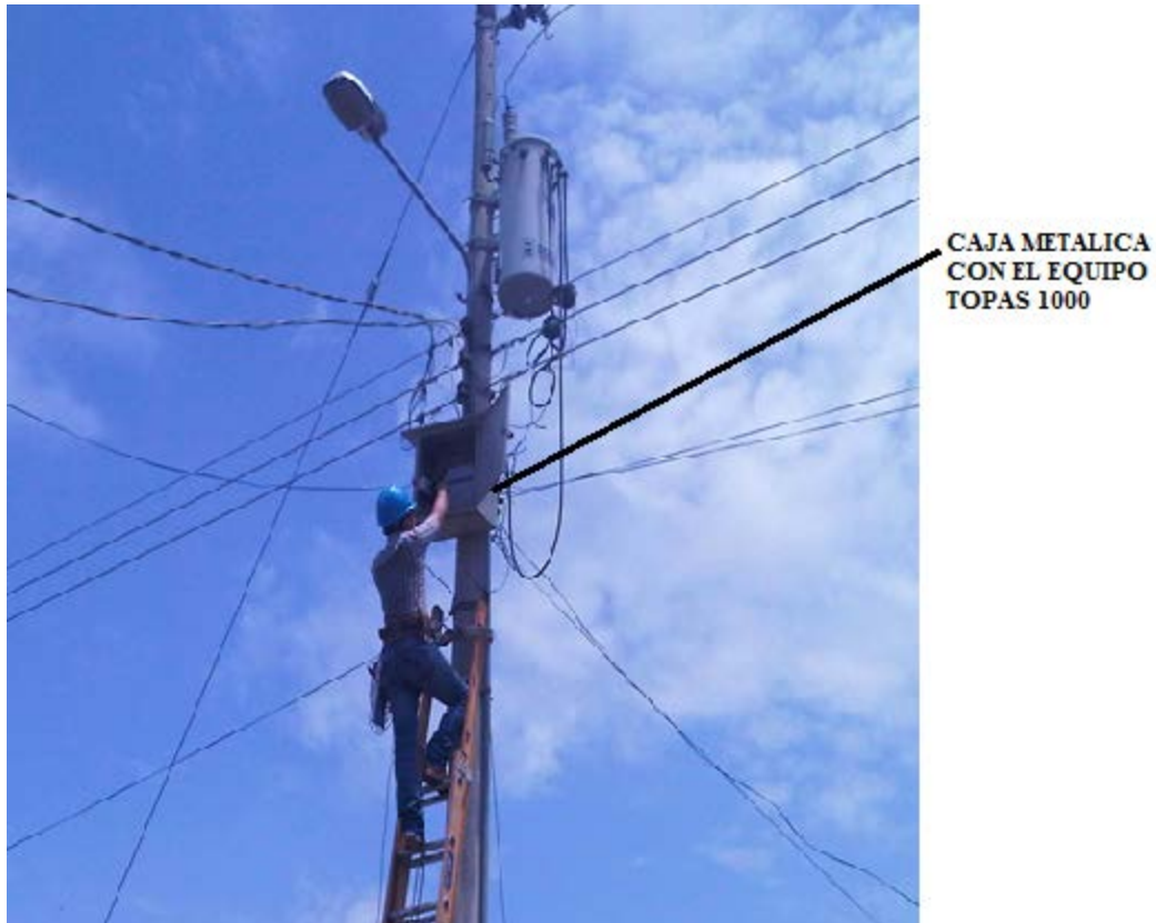
GRÁFICA 3.13 MONTAJE DEL EQUIPO TOPAS 1000
