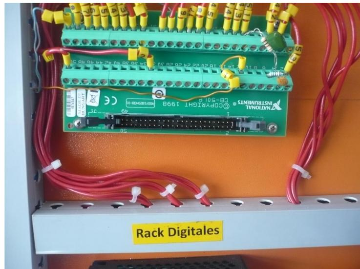
Figura 3.38 Rack 3 entradas y salidas digitales
