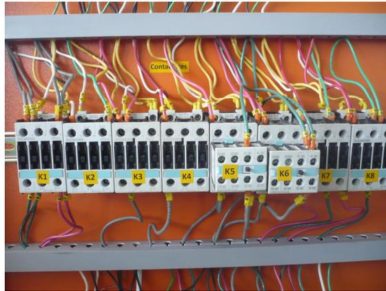
Figura 3.19 Instalación de contactores
