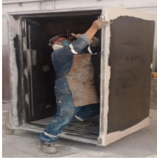
Figura 14. Masillado de caja
