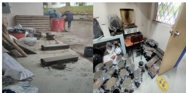
Figura 5. Elaboración de probetas de cilindros y vigas de hormigón
