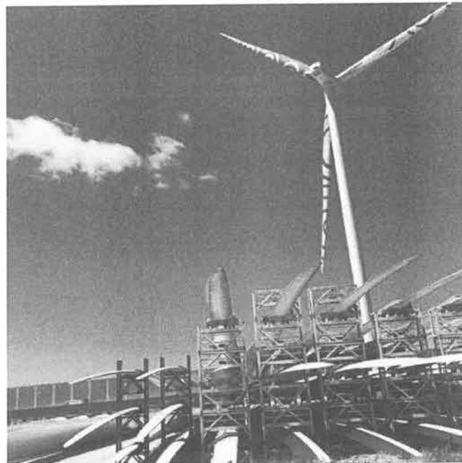
Fábrica de aspas de aerogeneradores de Siemens-Gamesa en Vago, Portugal.
