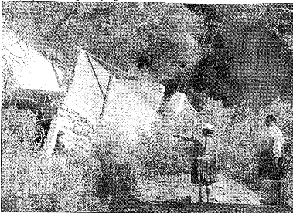
UNA CASA EN CONSTRUCCIÓN se vino a bajo en el sector de Santa Isabel, tras un macro deslizamiento de tierra que también agrietó la vía Girón-Pasaje. La alerta naranja se mantiene. FOTO: BR/HOY
