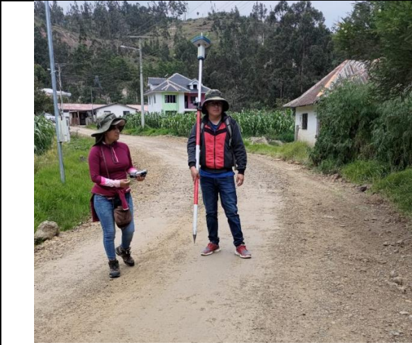
Toma de puntos de la carretera existente.
