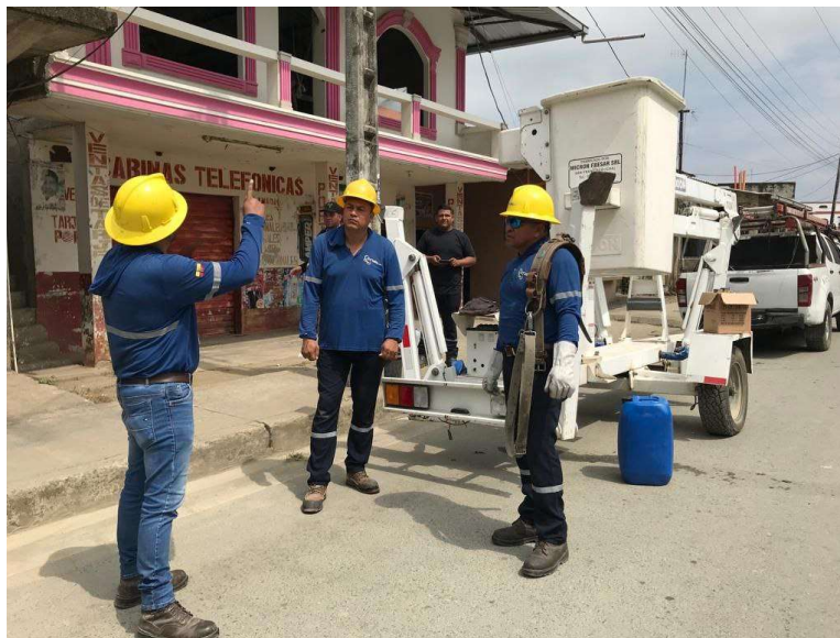
Figura 8. Profesional de alumbrado supervisando obra
