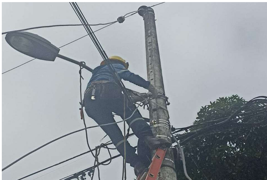
Figura 11. Técnico 2 realizando un trabajo de reparación del sistema de iluminación
