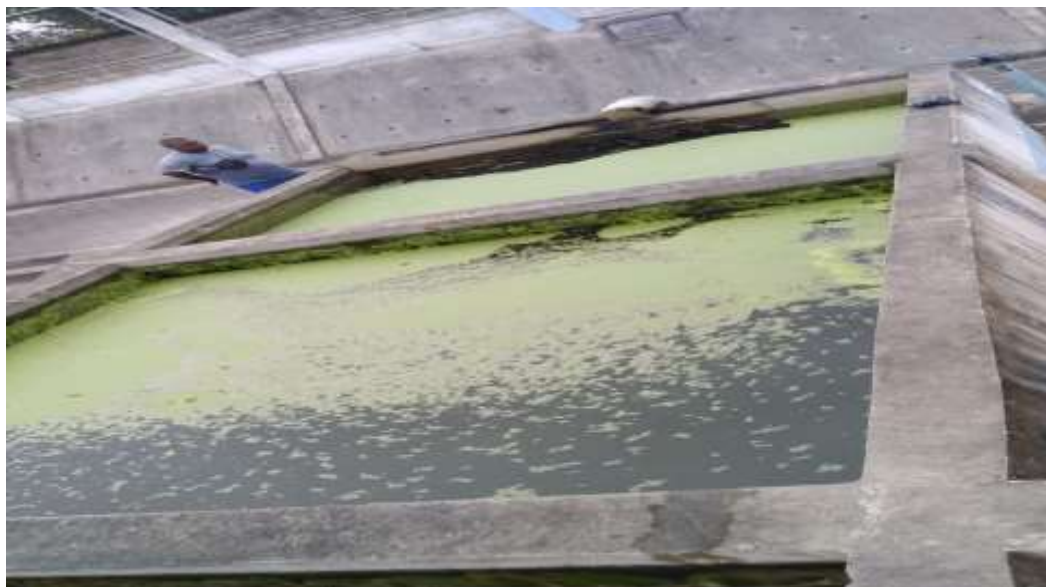
Figura 20. Desarenador
