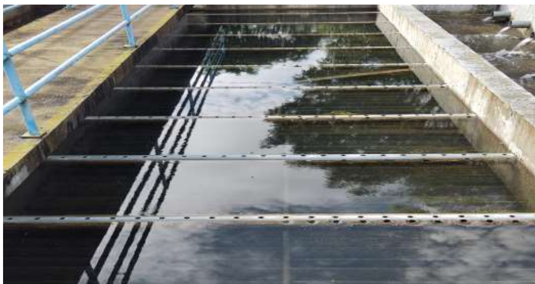
Figura 22. Sedimentadores
