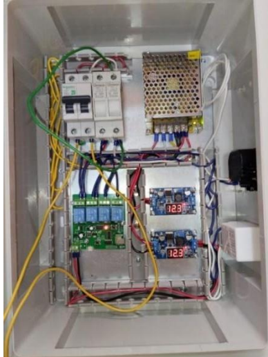
Figura 15: Prueba de los elementos conectados
