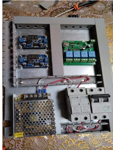
Figura 13: Instalación y empotrado de los elementos
