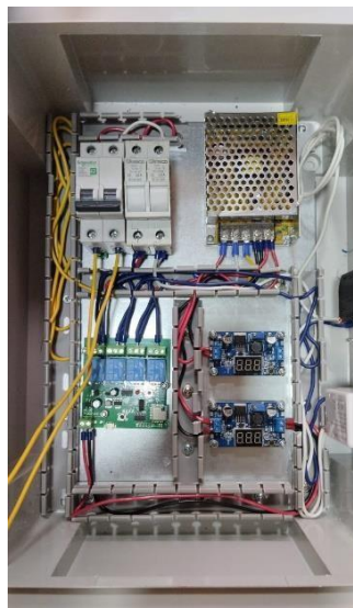
Figura 14: Cableado los elementos
