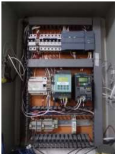
Figura 17. Implementación del proyecto, se visualiza 6,50HZ aproximadamente en los variadores
