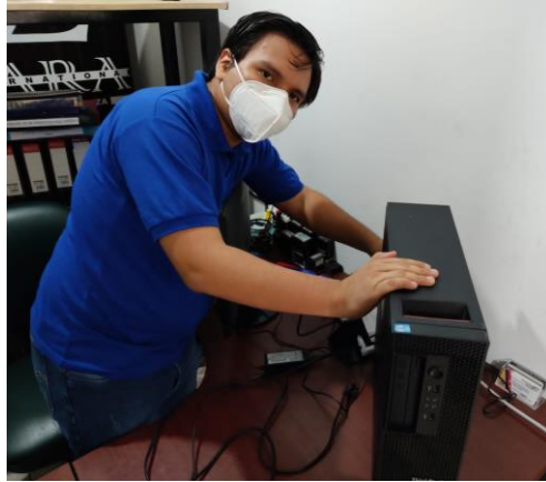
Figura 131. Instalación del Servidor Local Fuente: Elaboración propia de los autores
