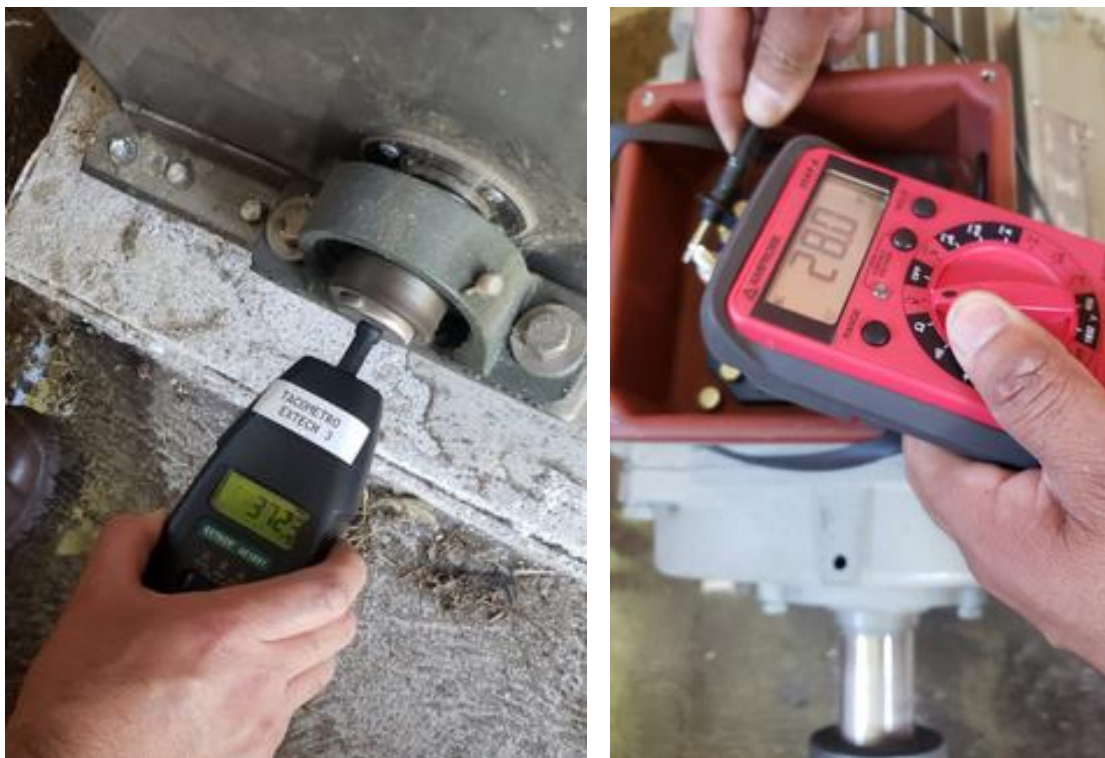
Figura 36. Medición de rpm de la turbina y voltaje del generador
