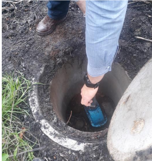
Figura 35. Válvula de compuerta de seguridad hacia la turbina
