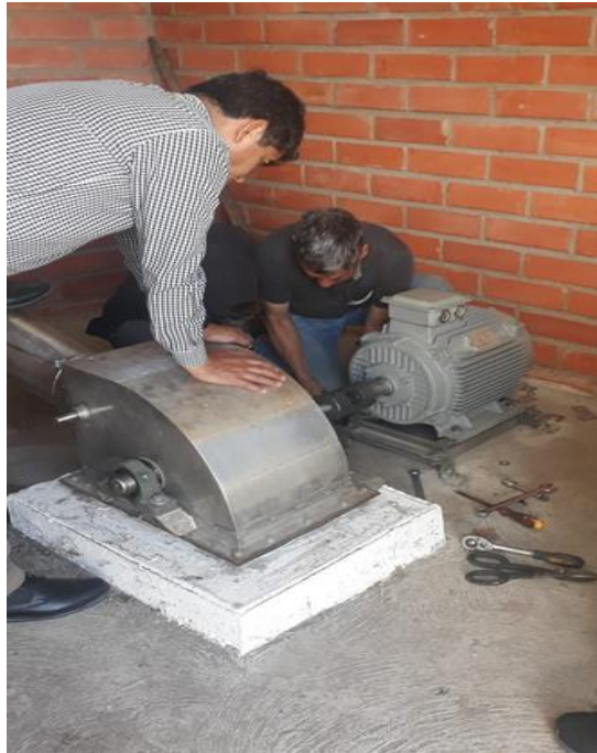
Fotografía del alineamiento del generador.
