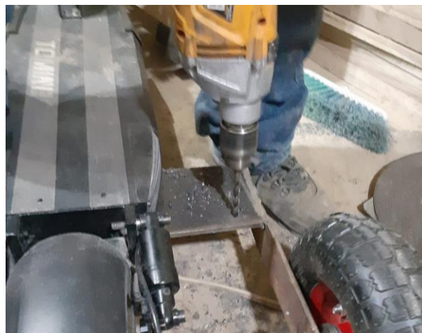
Figura 55. Perforación en la estructura.
