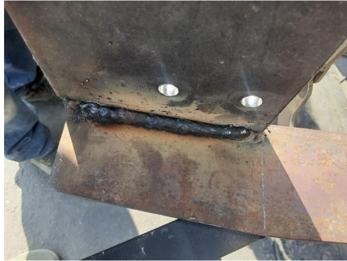
Figura 54. Soldadura de perfiles.
