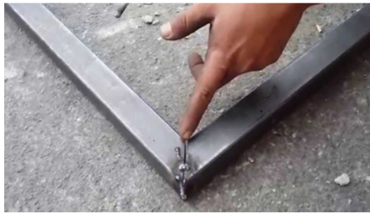
Figura 31: Soldadura aplicada por técnica de electrodos.
