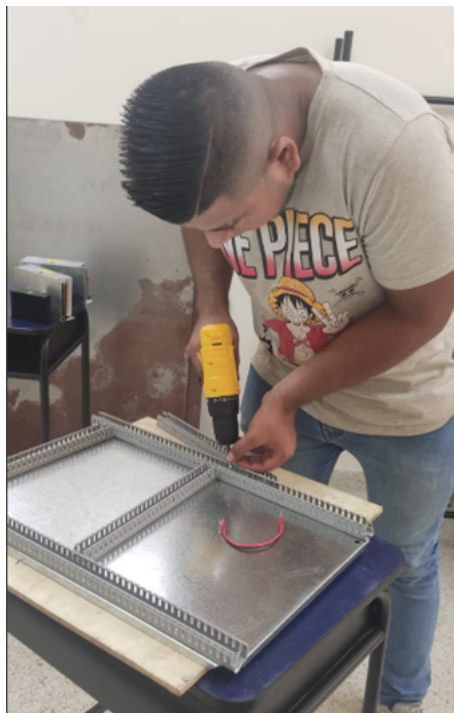
Figura 41: Instalación de canaletas.
