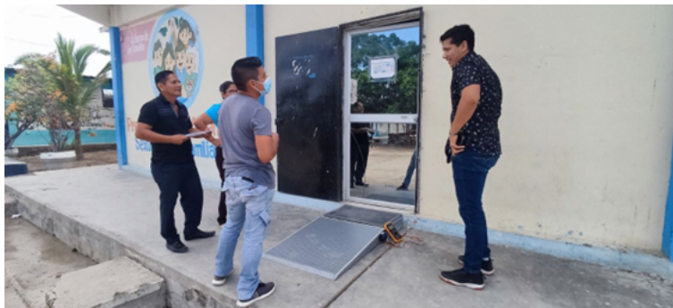
Figura 28. Realización de lecturas de tensión utilizando la alfombra.
