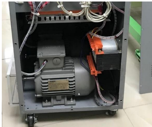
Figura 9. Mantenimiento a los motores
