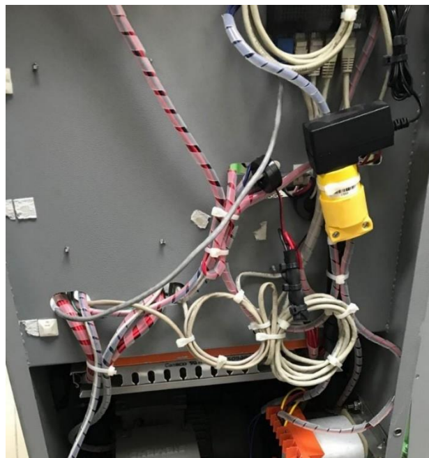
Figura 10. Reajuste de cableado
