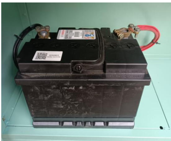
Figura 3-20. Instalación de la batería. 92
