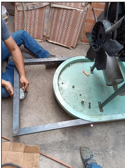
Figura 3-11. Construcción de la base del panel de diagnóstico. 83
