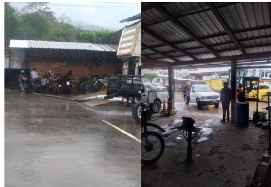
Figura 153 Área cubierta del taller
