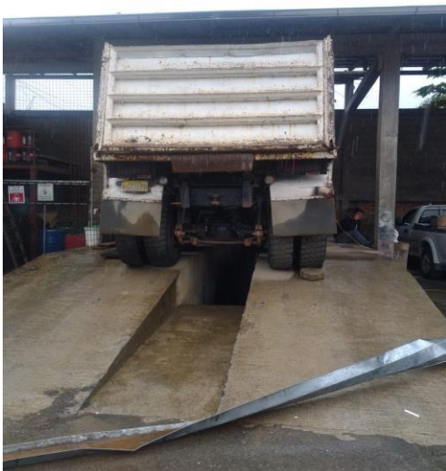
Figura 154 Rampa del Área de mantenimiento
