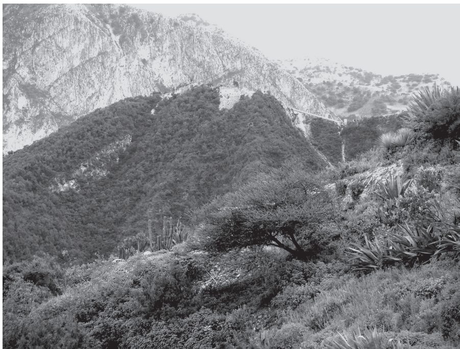
Foto 19.1. Vista del Acueducto II desde el cerro El Doctor, tomada por Luis Enrique Granados Muñoz.
