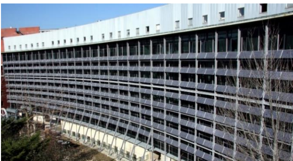
Fig. 2. Fachada fotovoltaica de la universidad de Cantabria
