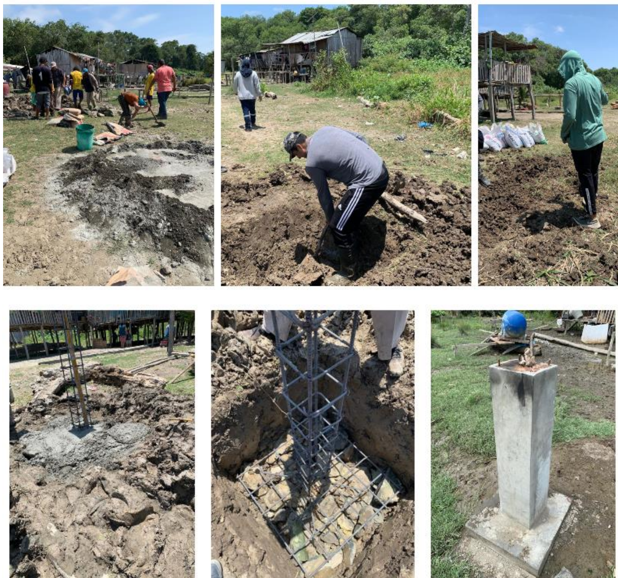
Figura 25. Construcción de las bases del panel solar
