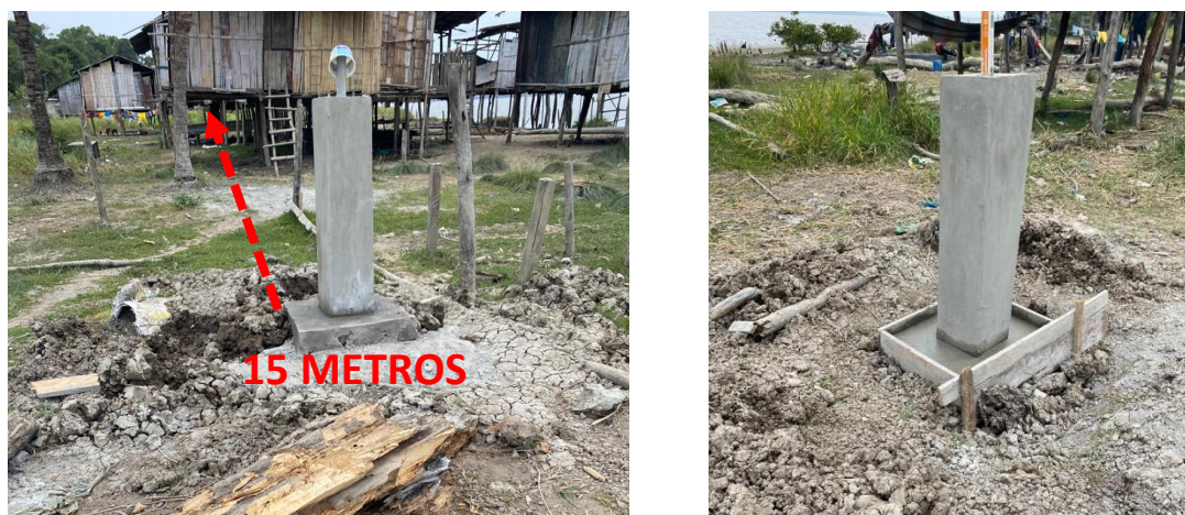
Figura 27. Distancia y ubicación de la base del panel
