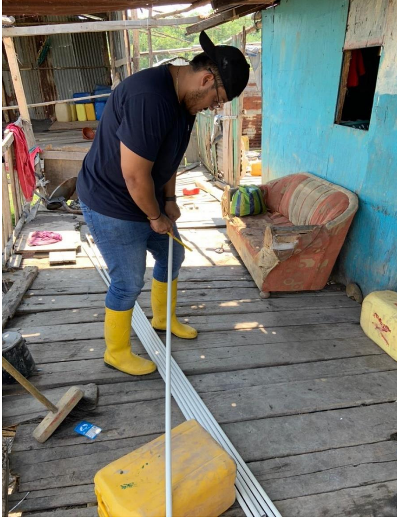
Figura 22.- Corte de tuberías a las medidas correspondientes
