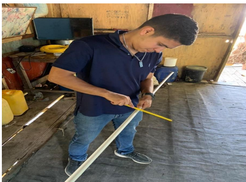
Figura 21.- Corte de tuberías a las medidas correspondientes
