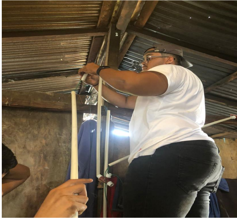
Figura 24.- Instalación de tuberías
