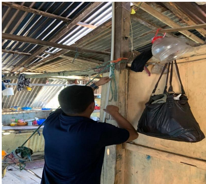
Figura 23.- Instalación de tuberías
