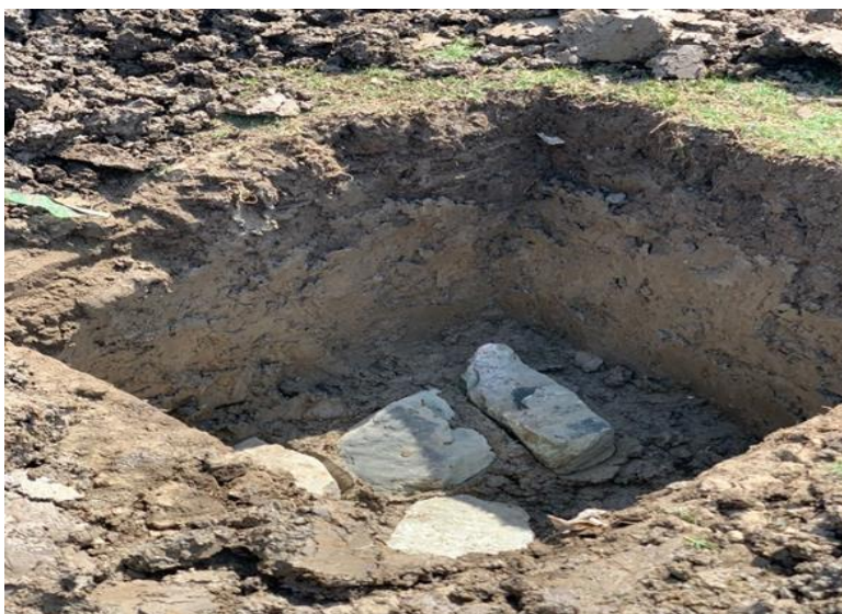
Figura 27 Preparación del terreno para la elaboración de la base del panel
