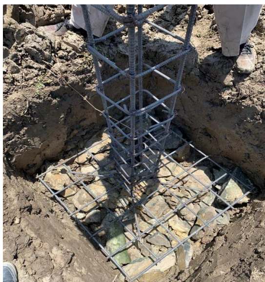
Figura 10 Armazón del plinto y pilar
