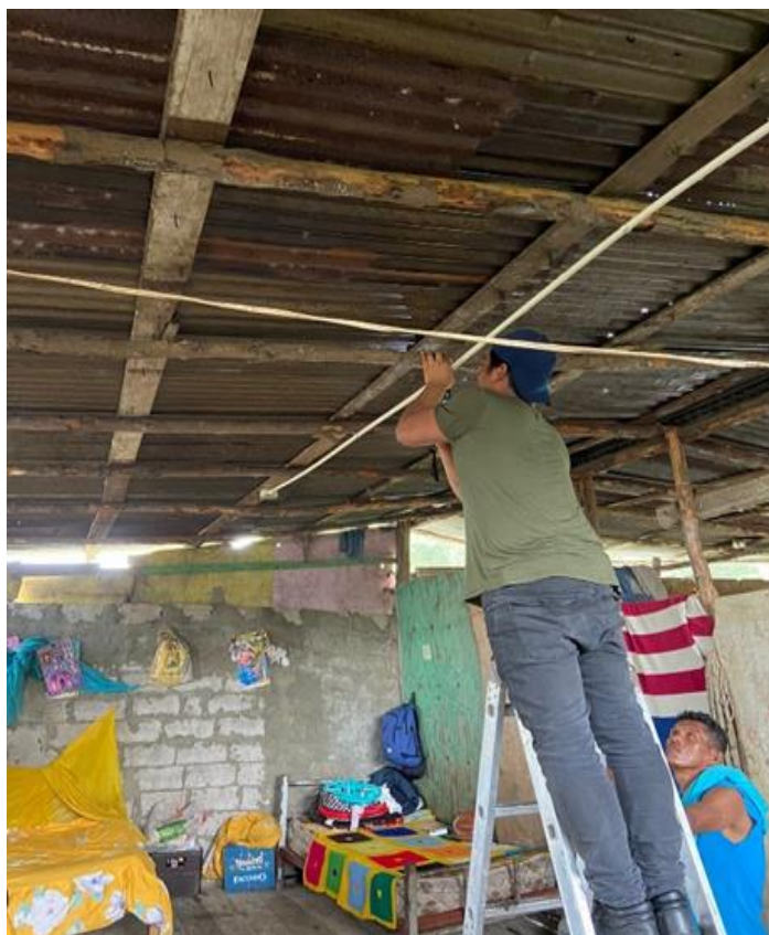
Figura 30 Instalación de tuberías en la vivienda
