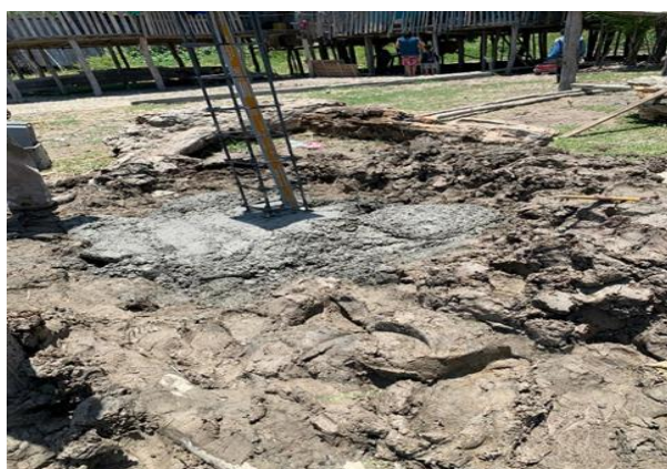
Figura 28 Relleno de la base del panel
