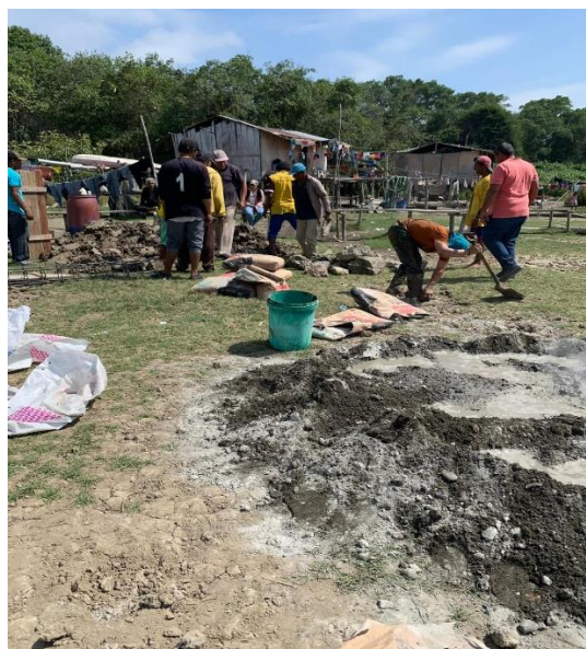
Figura 26 Preparación de concreto
