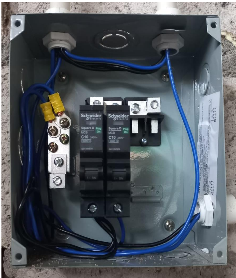
Figura 39 Instalación del panel eléctrico
