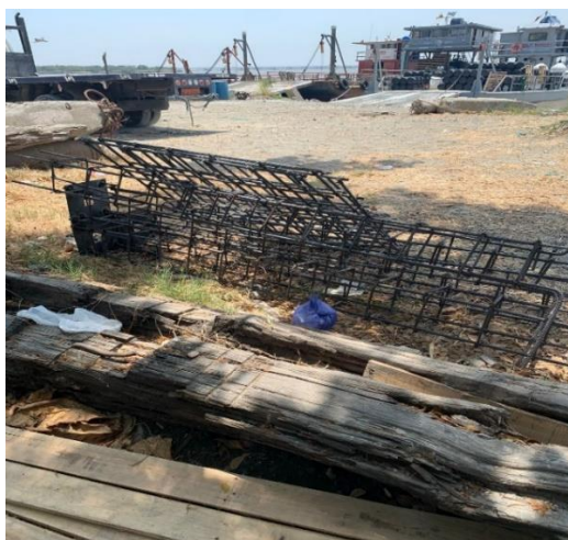
Figura 9 Prefabricación del pilar
