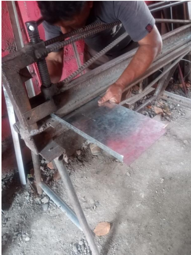
Ilustración 63: Construcción de base para inversor, regulador y baterías
