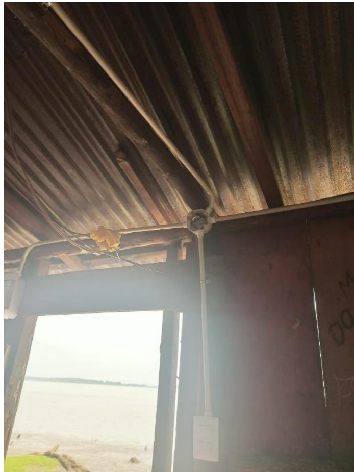
Ilustración 53: Instalación de caja de paso
