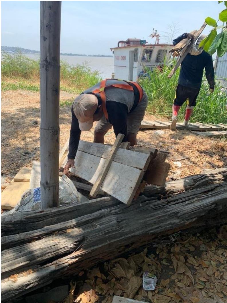
Ilustración 60: Construcción de base para panel solar
