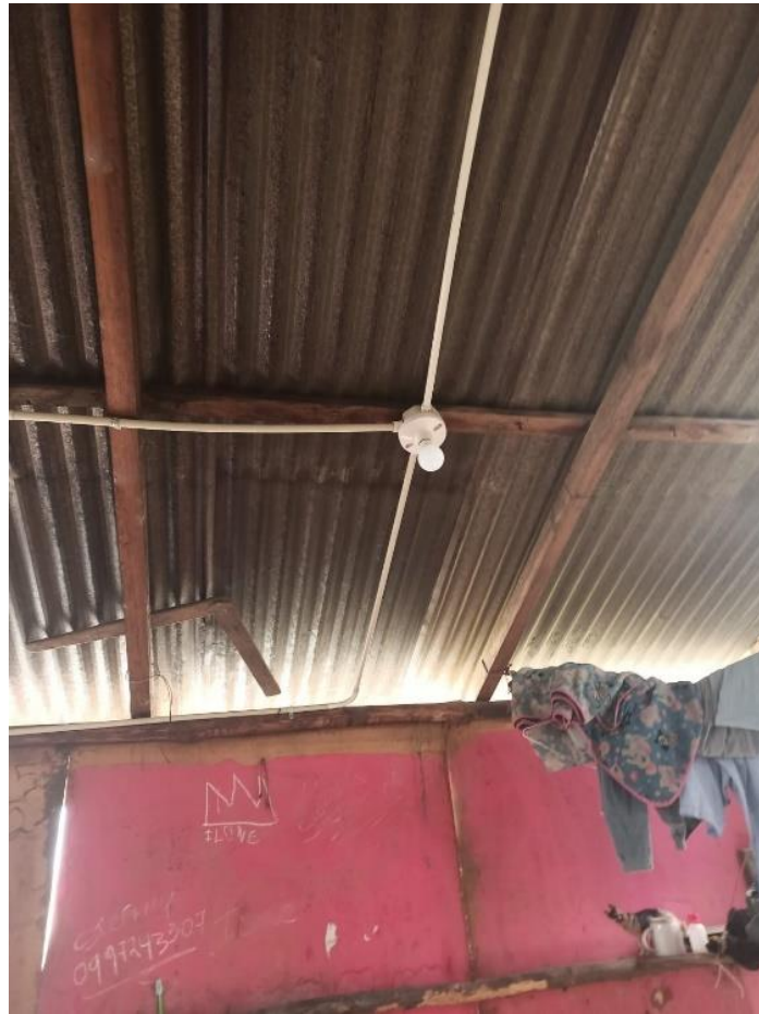
Ilustración 52: Instalación de iluminación
