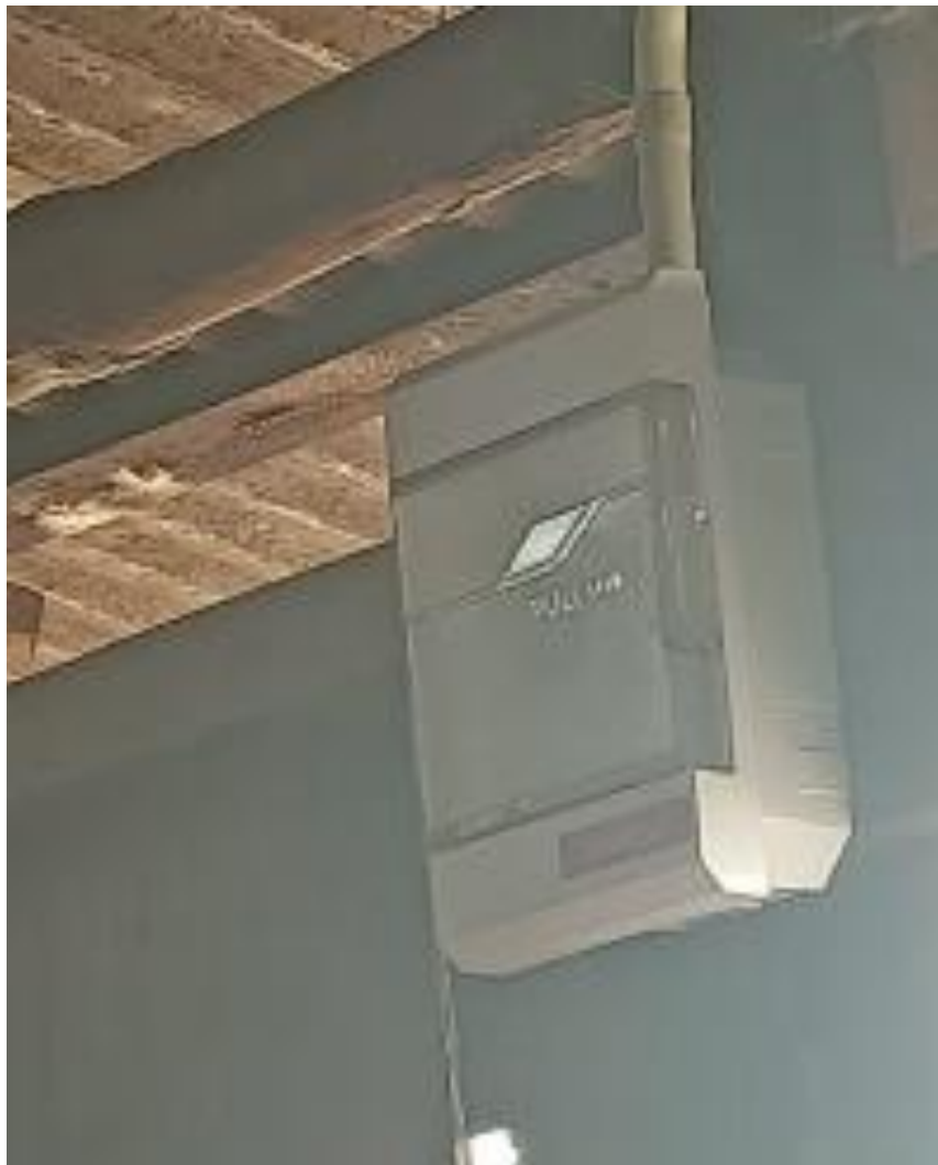
Ilustración 55: Instalación de caja de breaker
