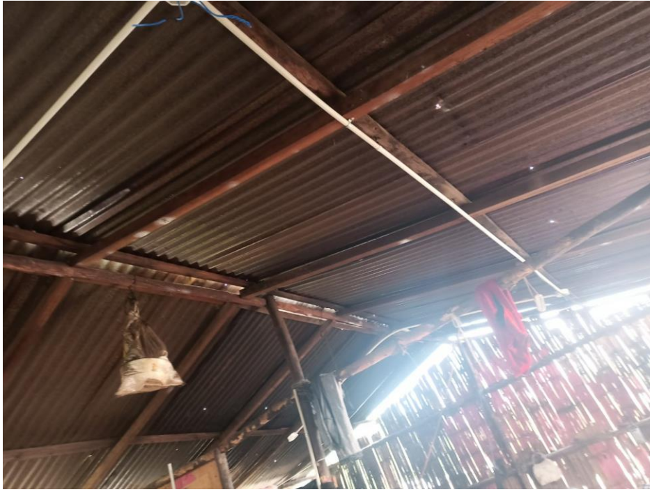
Ilustración 58: Instalación de tuberías para cableado
