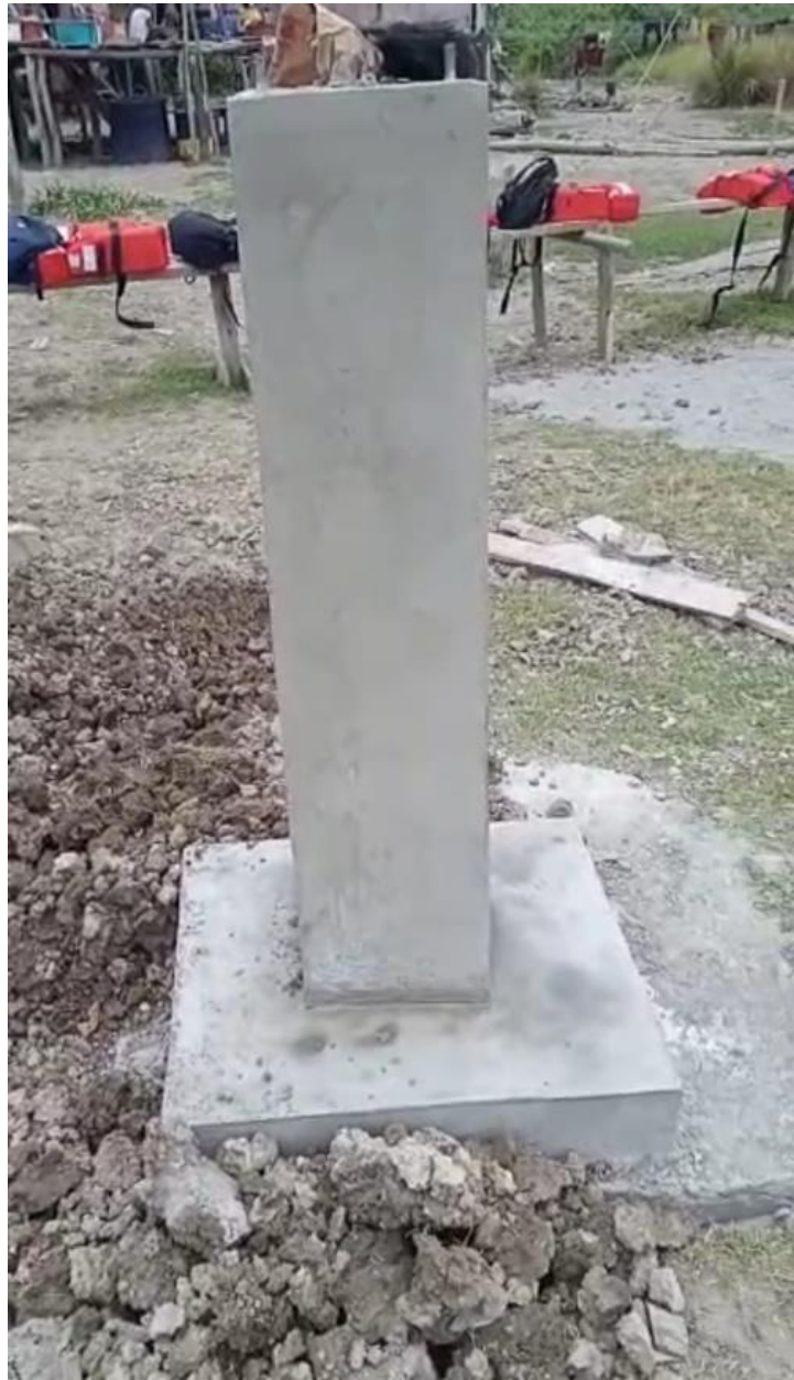
Ilustración 62: Resultado de implementación de base de panel solar
