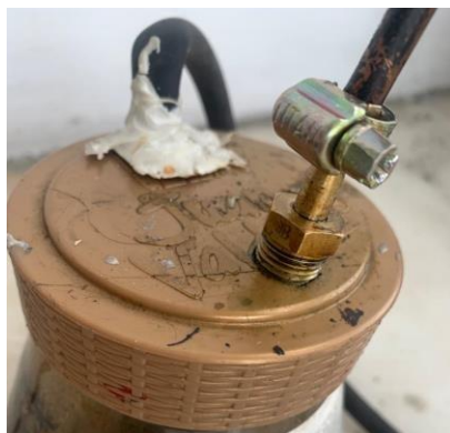
Ilustración No. 14: Entrada y salida del filtro de agua
