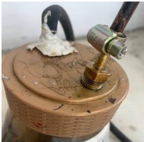
Ilustración No. 35: Acople hidráulico en el filtro de agua
