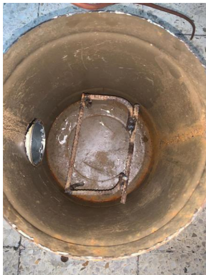
Ilustración No. 13: Estructura de la tolva de biomasa
