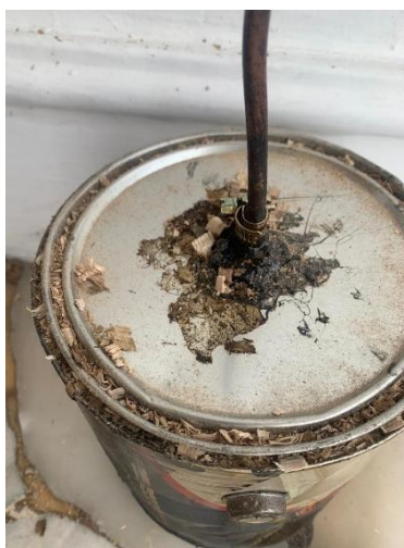
Ilustración No. 34: Acople hidráulico en la tolva de biomasa
