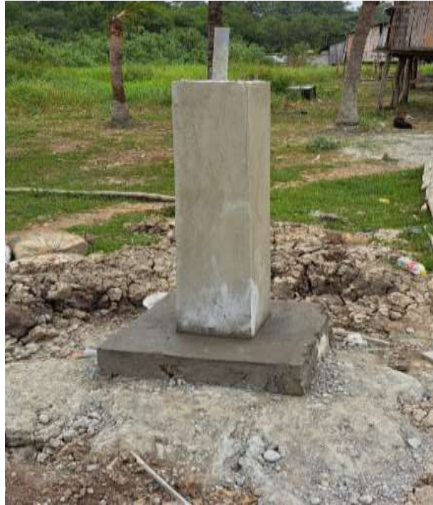
Figura 33: Pilar, dimensionado y seco.
