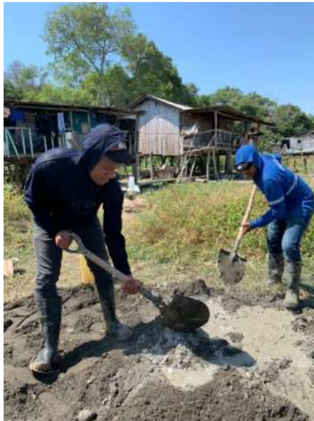
Figura 34: Mezcla de concreto para el relleno del pilar.
