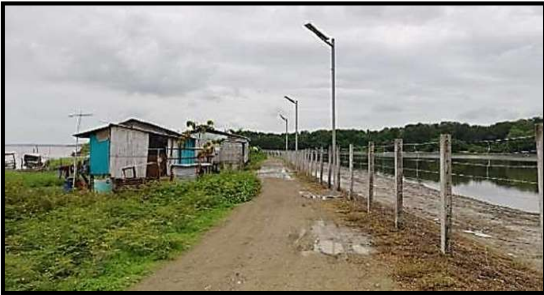
Figura 2: Vía principal alumbrada con sistema solar fotovoltaico de la comunidad Masa 2. Fuente: [1]
