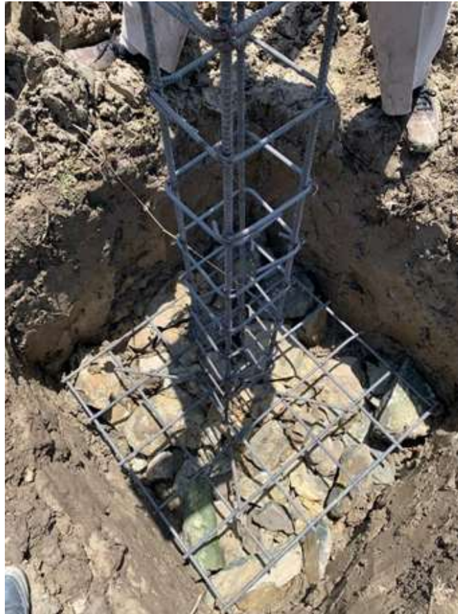
Figura 8: Montaje de la estructura para el pilar. Fuente: Los autores
