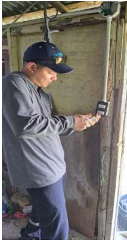
Figura 35: Instalación de un interruptor doble.
