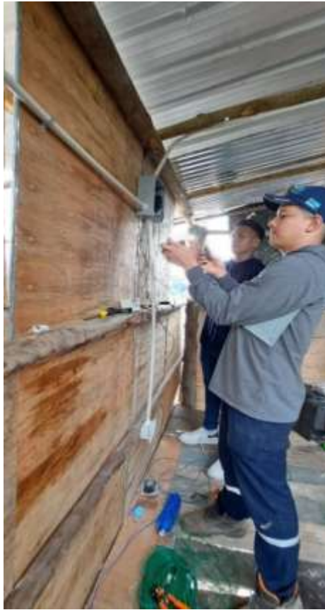
Figura 37: Instalación de la caja de beakers eléctrico.
