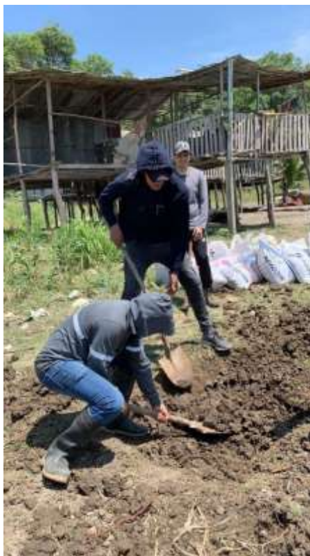
Figura 32: Excavación de la base.
