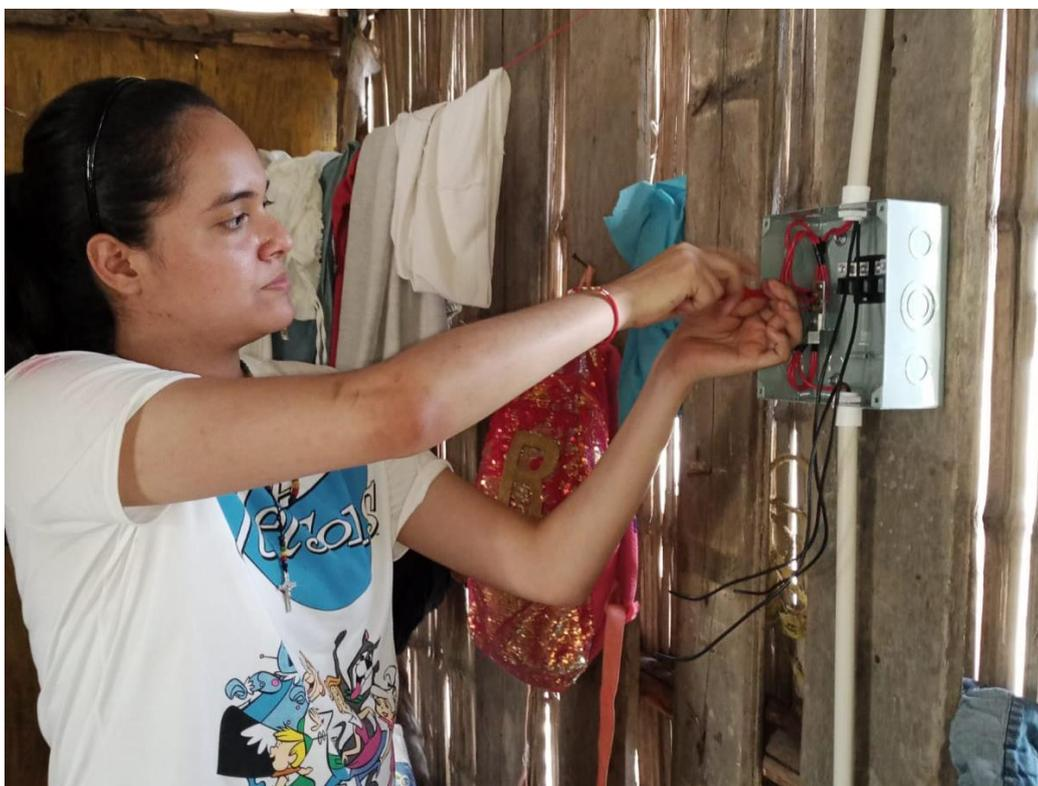
Figura 35. Conexión de línea en panel de distribución (Fuente: Autores).
