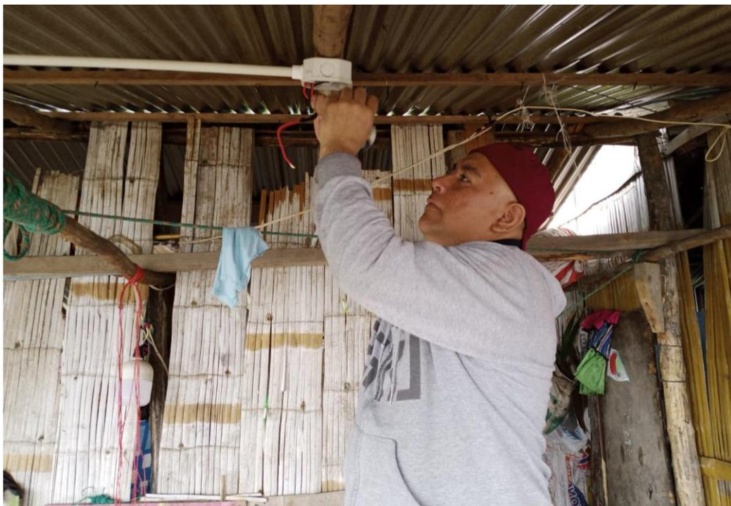
Figura 40. Conexión de boquilla (Fuente: Autores).
