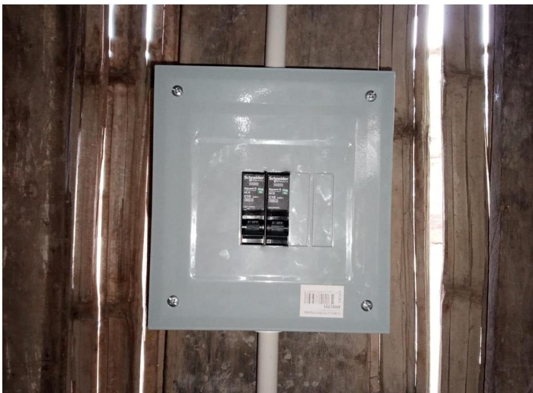
Figura 51. Panel de distribución de la vivienda, con dos disyuntores de 10Amp (Fuente: Autores).
