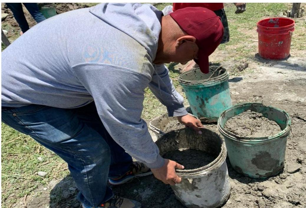
Figura 21. Elaboración de la mezcla del hormigón (Fuente: Autores).
