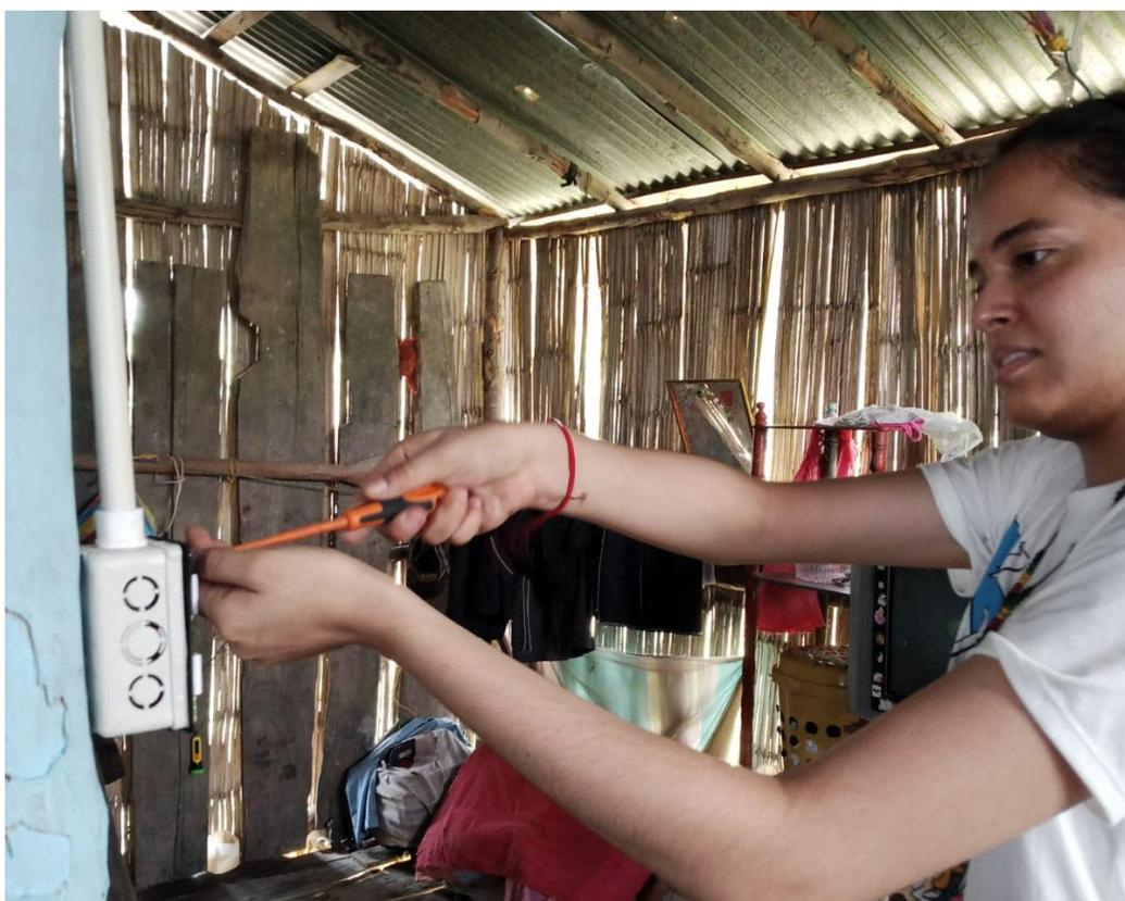
Figura 31. Conexión de interruptor doble (Fuente: Autores).
