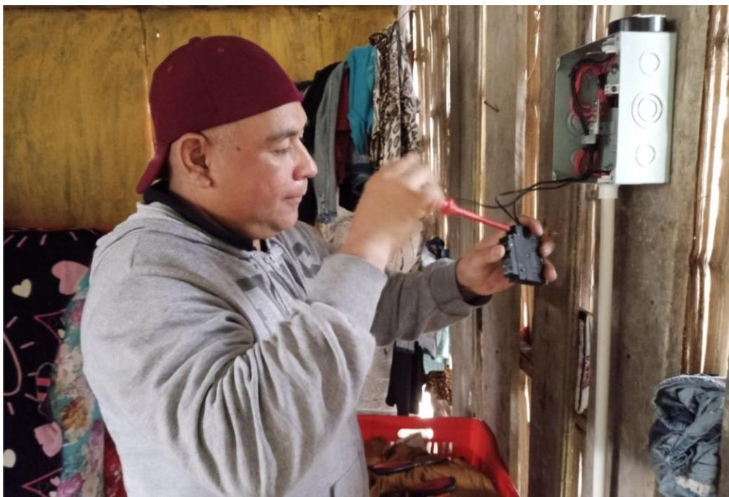
Figura 38. Conexión de Disyuntor (Fuente: Autores).
