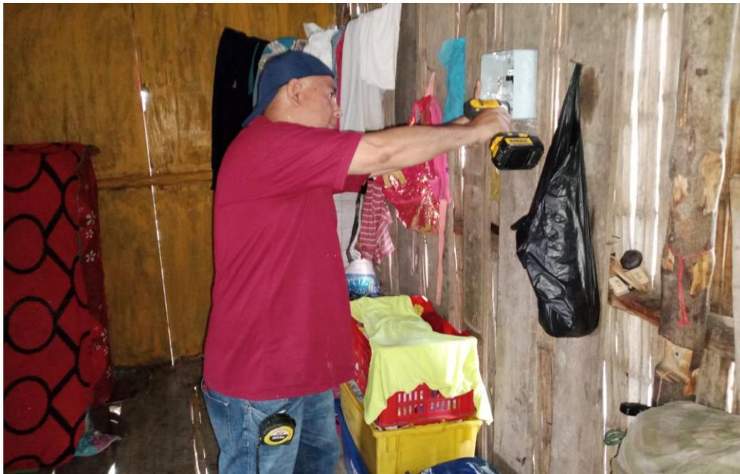
Figura 26. Fijación del panel de distribución de la vivienda (Fuente: Autores).
