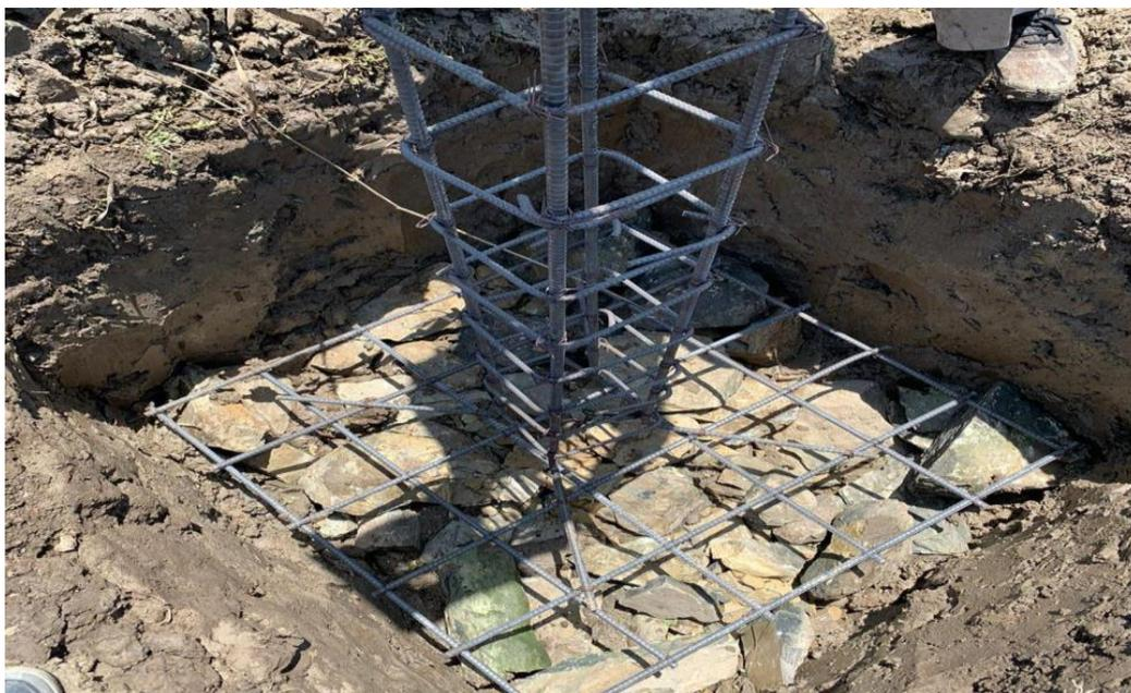
Figura 20. Excavación de 1 m de profundidad para las zapatas. Colocación de piedras en la base inferior de la zapata, y encima la estructura de varillas (Fuente: Autores).
