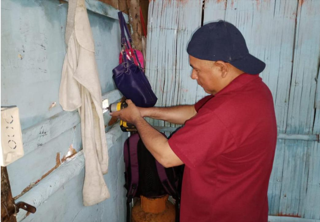
Figura 28. Fijación de caja rectangular PVC para tomacorriente (Fuente: Autores).
