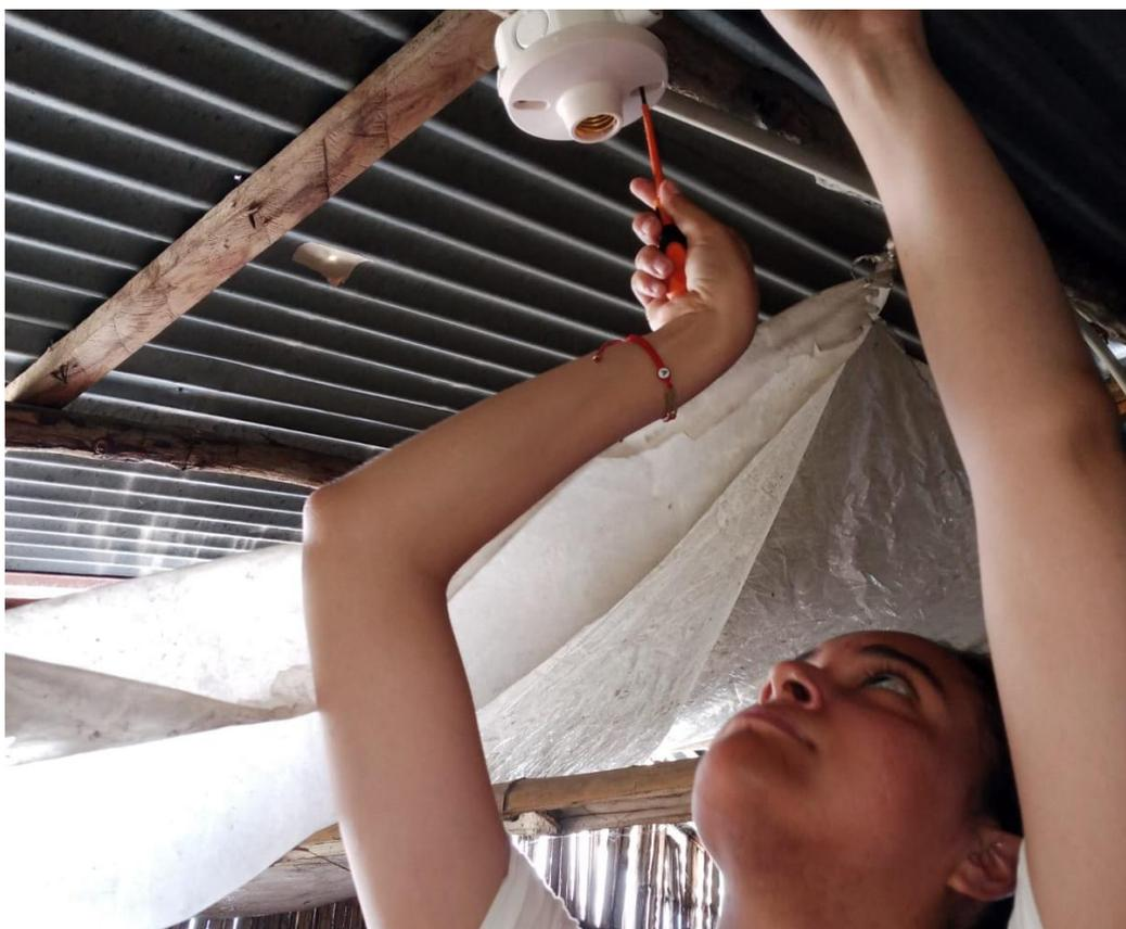
Figura 33. Instalación de boquilla (Fuente: Autores).
