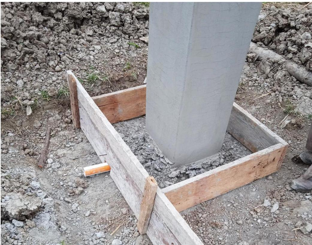
Figura 23. Colocación del encofrado para la creación de la base superior de la zapata (Fuente: Autores).
