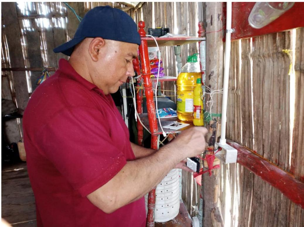
Figura 32. Conexión de tomacorriente de 120V (Fuente: Autores).
