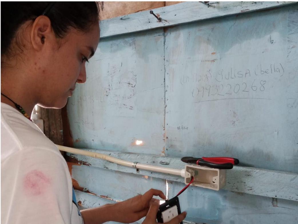
Figura 29. Conexión de tomacorriente de 120V (Fuente: Autores).
