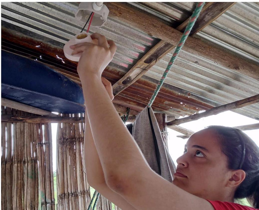
Figura 41. Instalación de boquilla (Fuente: Autores).
