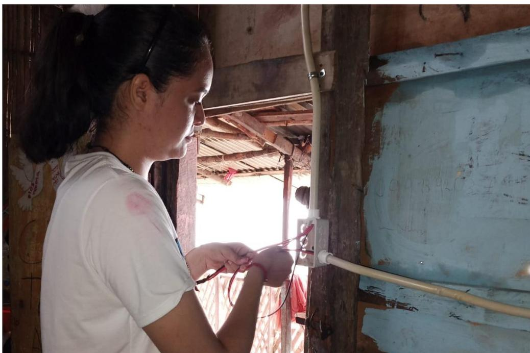
Figura 27. Conexión de interruptor doble (Fuente: Autores).
