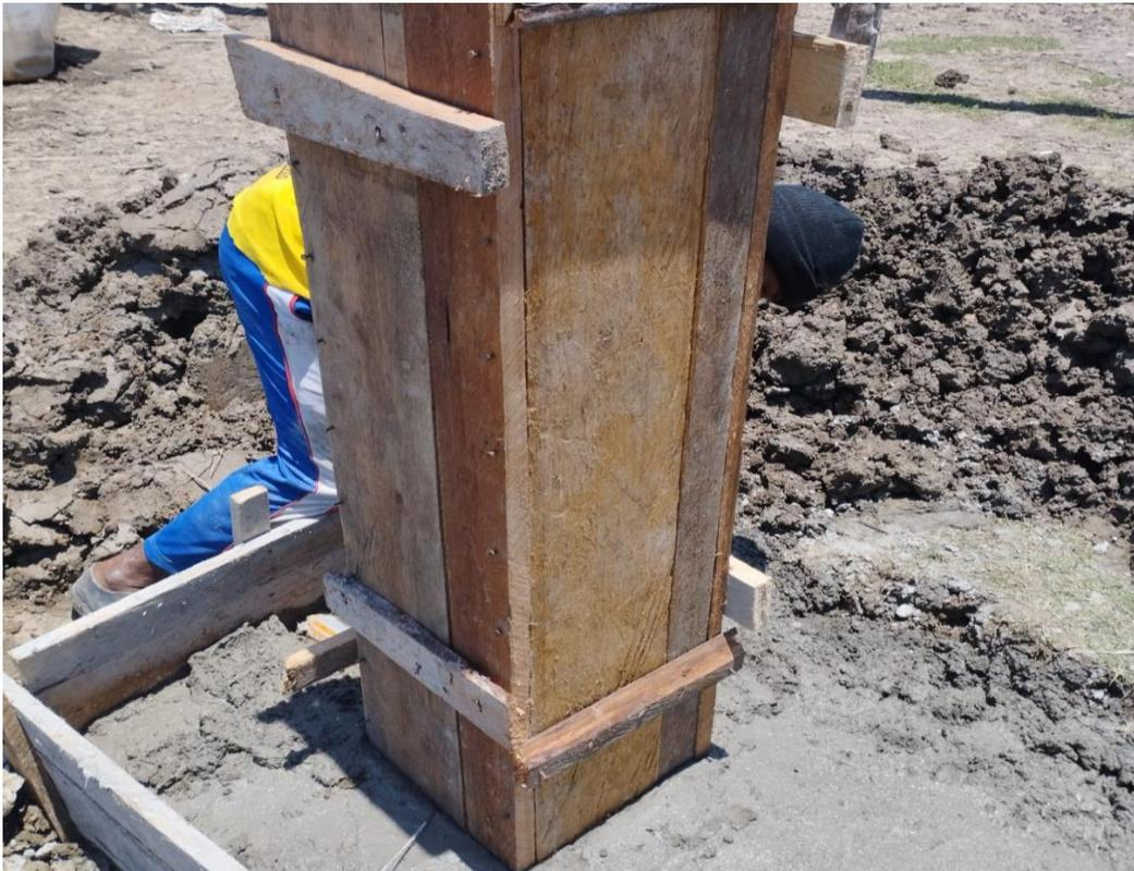
Figura 22. Colocación del encofrado para la creación del pilar (Fuente: Autores).
