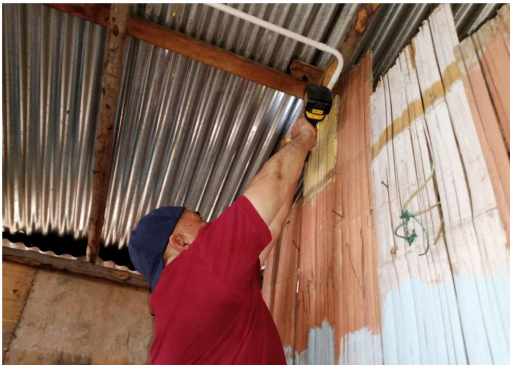
Figura 30. Fijación de tubería PVC de ½'' (Fuente: Autores).
