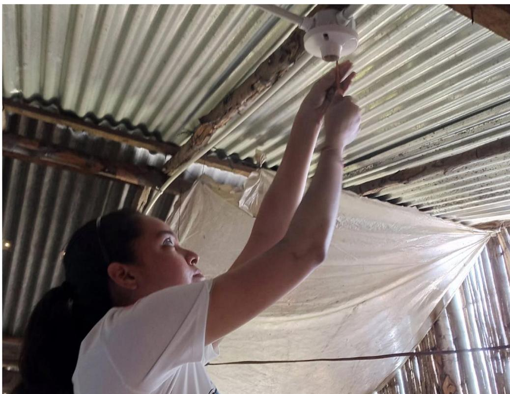
Figura 37. Instalación de boquilla (Fuente: Autores).
