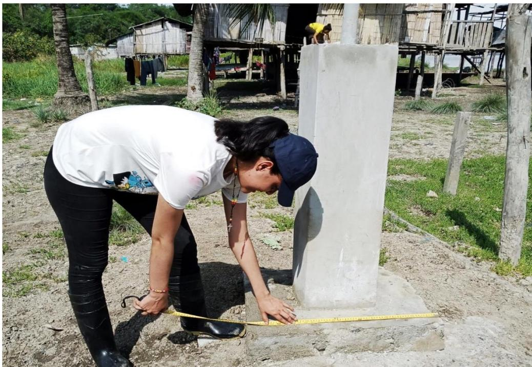
Figura 24. Medición de las longitudes de la zapata terminada (Fuente: Autores).
