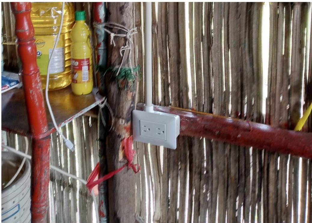
Figura 44. Tomacorriente de 120V en la cocina (Fuente: Autores).
