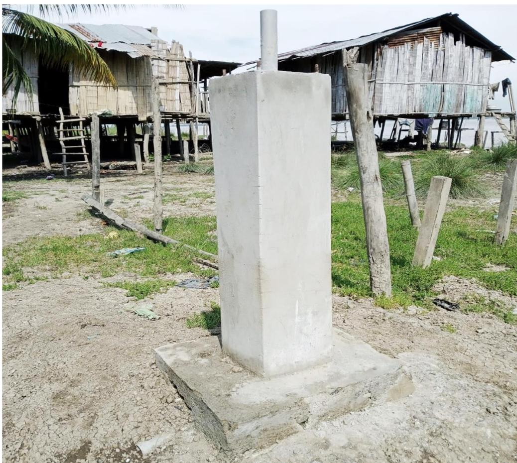
Figura 25. Zapata aislada terminada, para la instalación de estructura base de paneles solares (Fuente: Autores).
