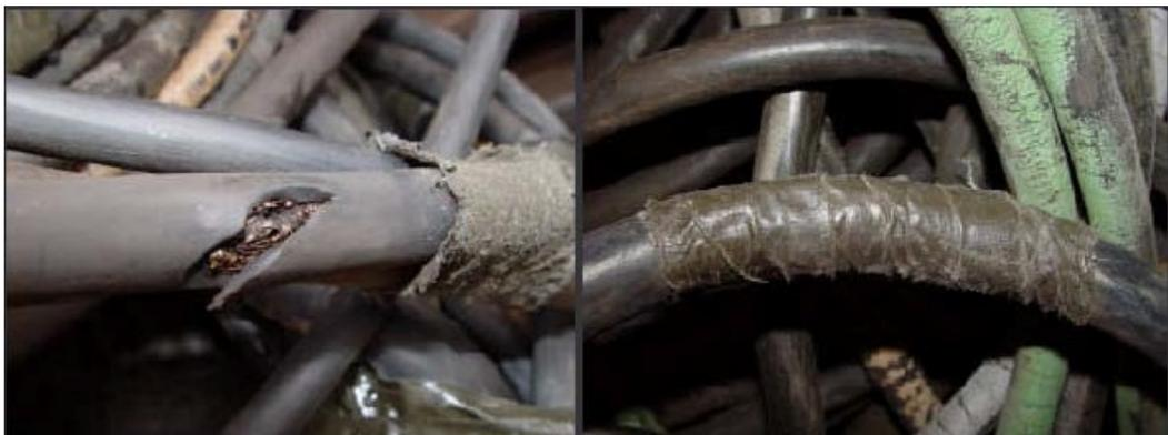
Figura 4.28.9.10.b: Acometidas eléctricas inapropiadas.
