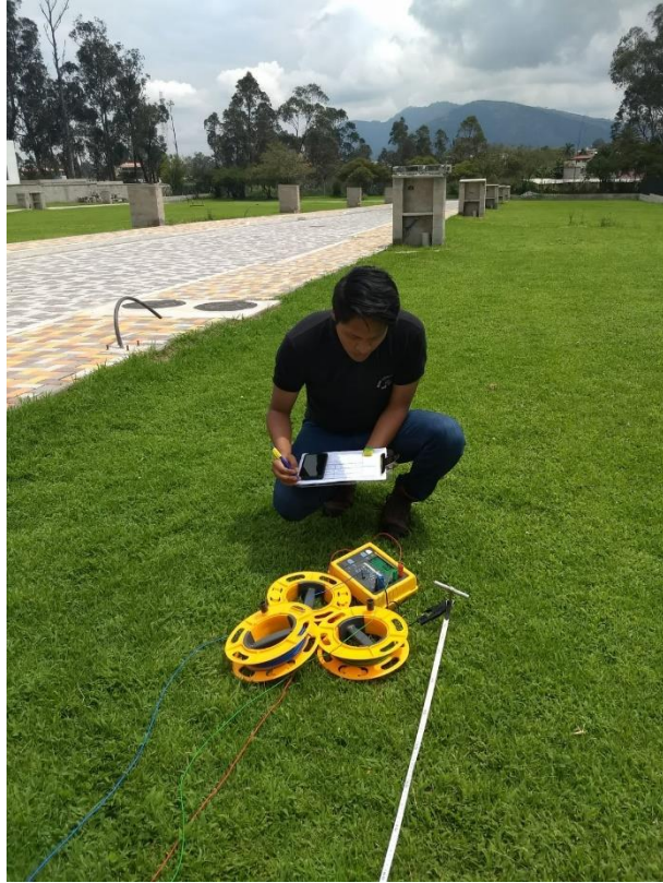
Figura 17. Ejecución del telurómetro - Conjunto San Simón 1 de Conocoto
