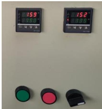
Figura 56: Implementación de los controladores de temperatura.
