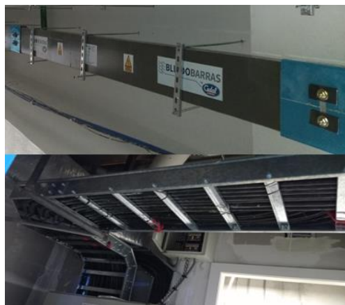
Figura 27 Instalación cables eléctricos vs blindobarra.
