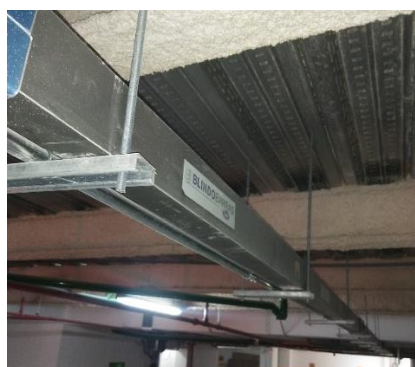
Figura 15 Blindobarra tipo alimentador. Fuente: Blindobarras by Cedal.
