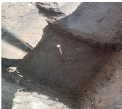
Figura 4 Pozo para implementación de malla a tierra. Fuente: Endara Instalaciones.
