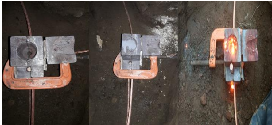
Figura 8 Soldadura Exotérmica. Fuente: Endara Instalaciones.
