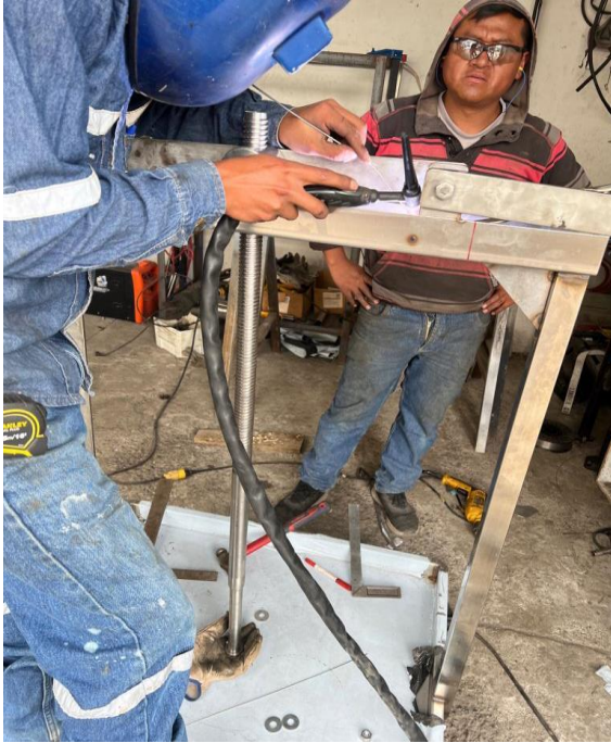
Figura 61. Proceso de soldadura.
