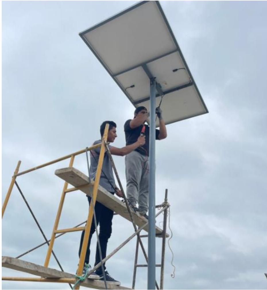
Figura 39. Colocación y conexión del panel solar fotovoltaico. Fuente: Los autores
