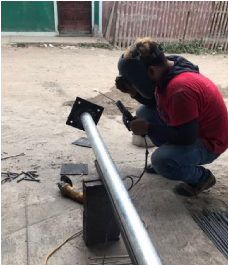
Figura 37. Construcción de la base del panel solar. Fuente: Los autores
