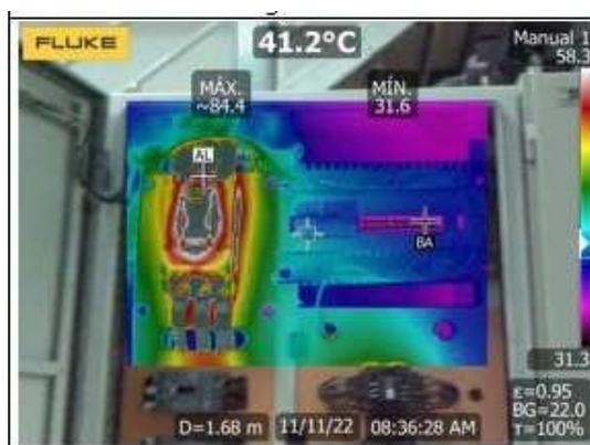
Figura 60 Termografía de breaker principal del banco de capacitores #3
