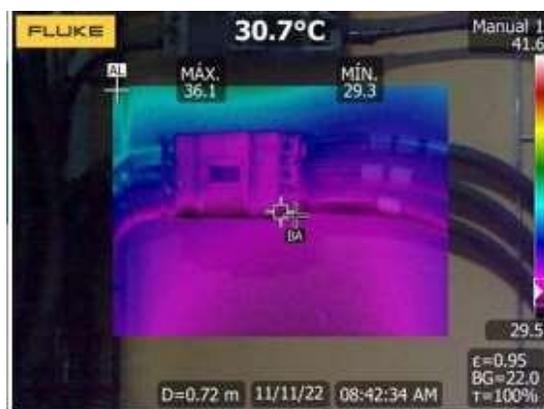
Figura 58 Termografía de breaker principal del banco de capacitores Fava 2200
