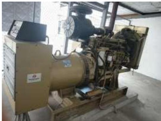
**Figura 26** Generador 200 kw
