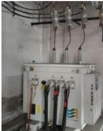
**Figura 25** Transformador trifásico N°1 750 KVA
