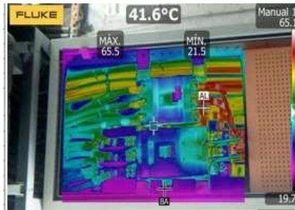
**Figura 52** Termografía de los breakers principales
