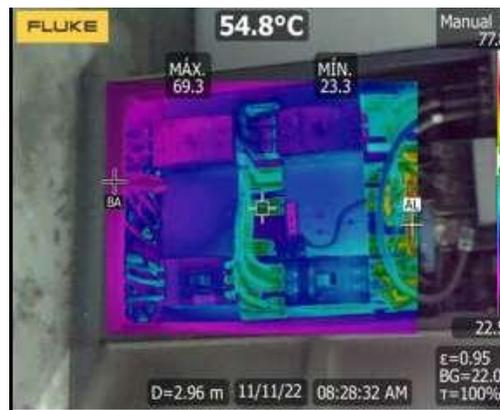
**Figura 65** Termografía de los breakers secundarios del proceso Pavan B1000-B600
