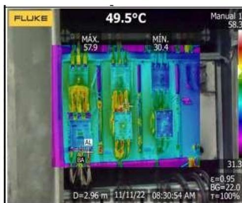
**Figura 67** Termografía de los breakers secundarios del banco de capacitores #1
