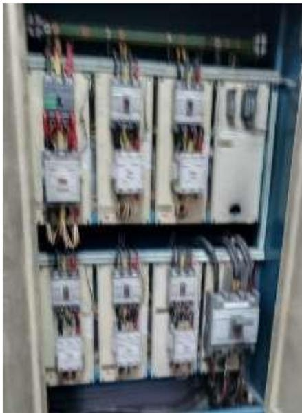
**Figura 32** Tablero de banco de capacitores #1
