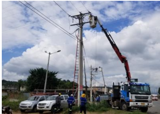
Figura 1 Lugar de reconocimiento redes de distribución Viche – El Roto, Quinindé (CNEL Esmeraldas).
