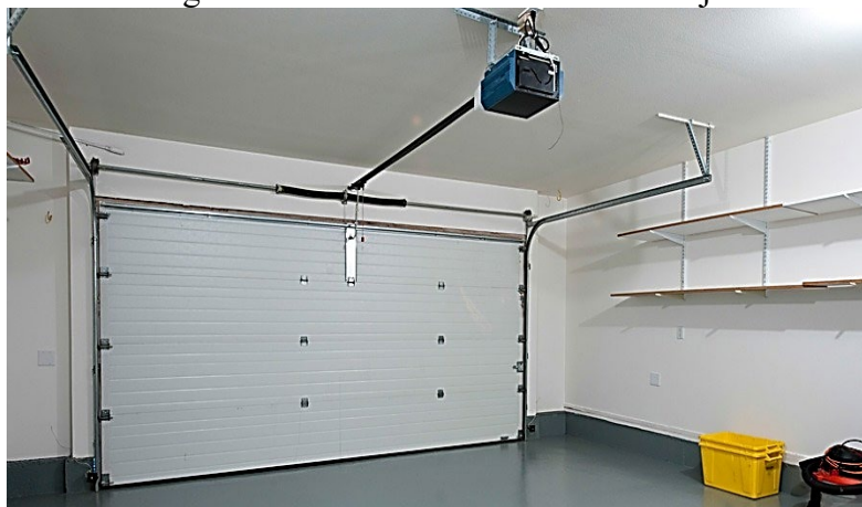
Figura 2.1: Puerta Automática de Garaje
