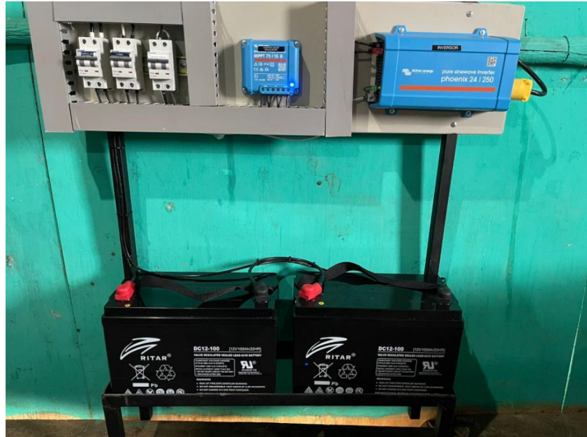
Figura 36. Sistema fotovoltaico concluido para las pruebas de funcionamiento
