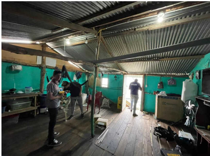
Figura 37. Prueba de funcionamiento de las luminarias
