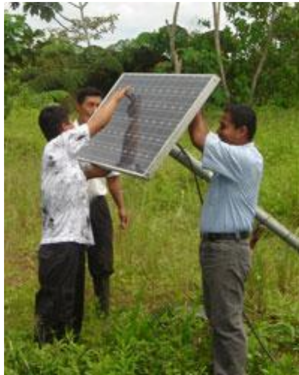
Figura 2. Instalación de un panel solar fotovoltaico
