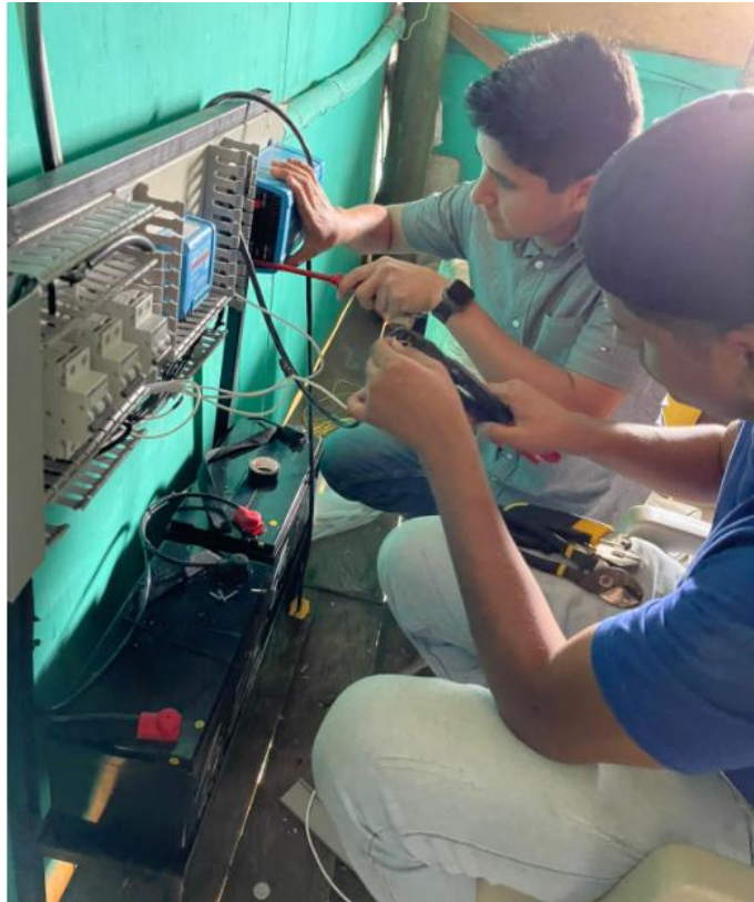
Figura 34. Conexión eléctrica de los componentes del SF
