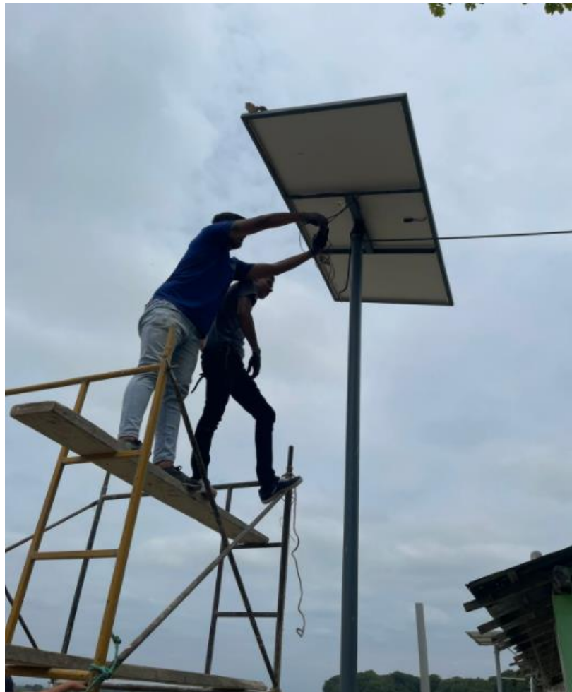
Figura 33. Montaje del panel solar de 405 W.
