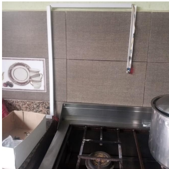
Posición del Sensor detector de gas. Fuente: Hernández K, Quishpe L.
