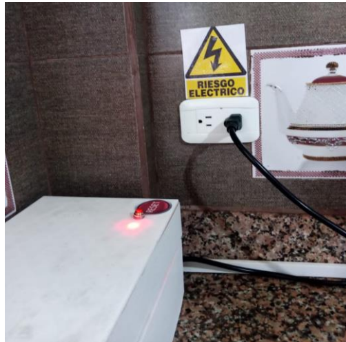
Figura 4.1: Instalación del dispositivo
