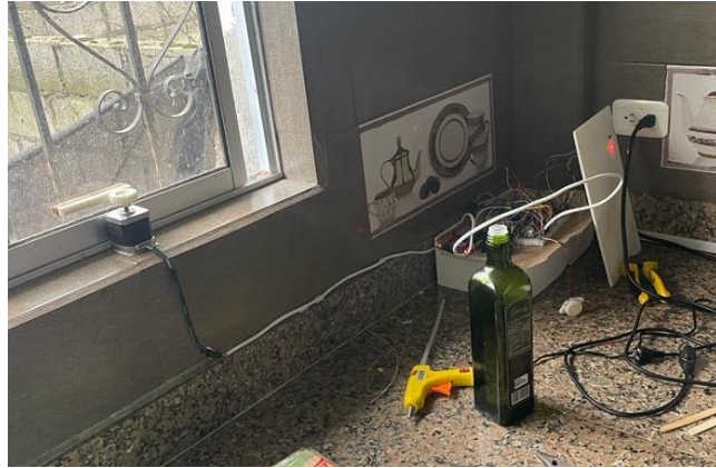
Figura 3.18: Proceso de instalación del dispositivo
