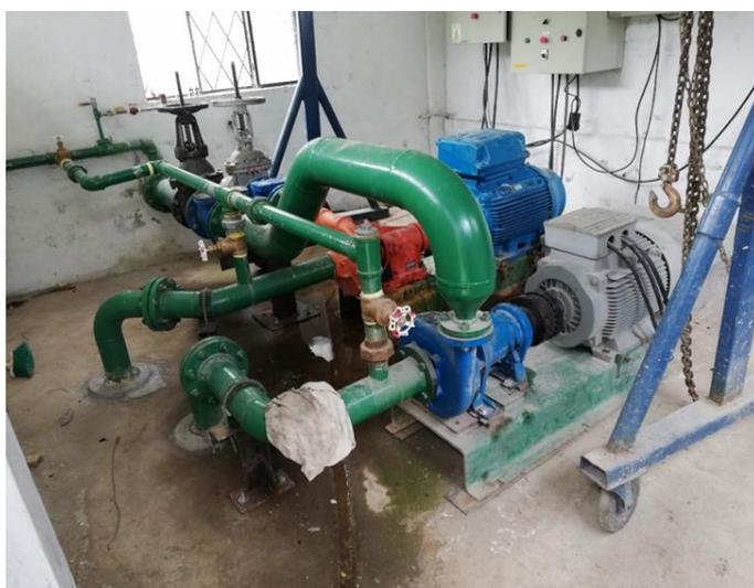
**Figura 13.** Sistema de conexión del cuarto de bombas del tanque C.
