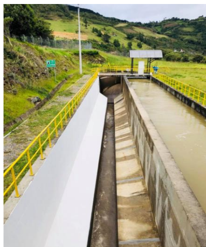
Figura 3. Desarenador de captación de la Central Hidroeléctrica Alazán. Fuente: Autor, 2022.
