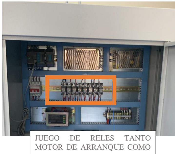
Figura: 1.7 Circuito de relés
