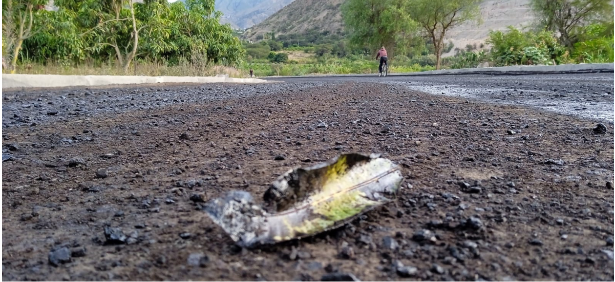
Puente recién asfaltado.
