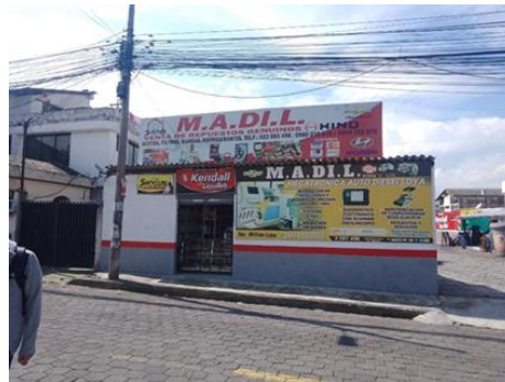
Figura 8.8: Infraestructura del taller
