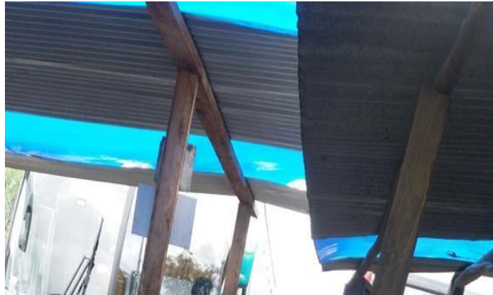
Ilustración 6 Cubierta del taller
